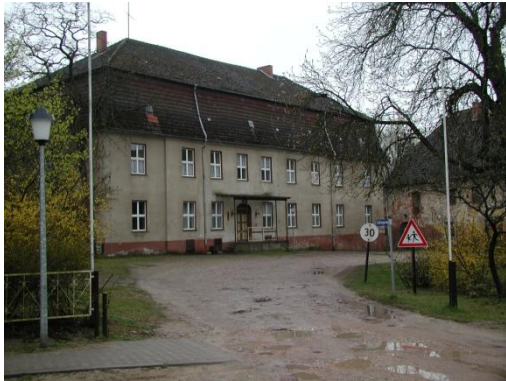
Das ehemalige königliche Amtshaus Erbaut 1754 vor der Sanierung 2002
