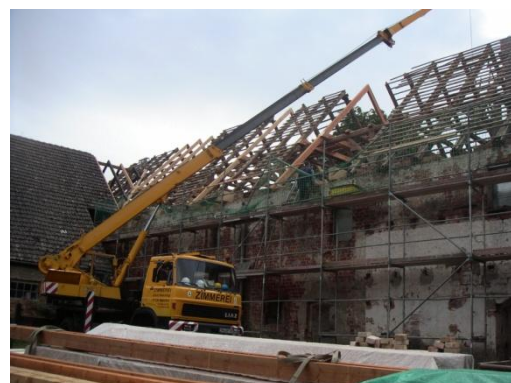
Reparatur des Dachstuhls des
